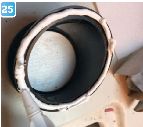
25 Sikaflex appliceras runt tankens nederkant.
