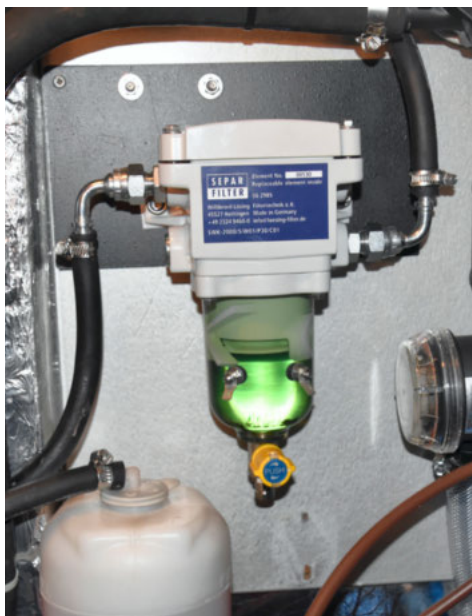
När vi ändå bytte filterhållare passade vi på att snygga till med nya slangar till tanken.
