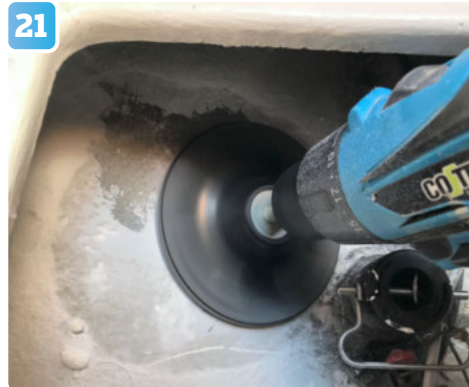
21 Glasfiberlaminatet på plats har en del struktur och slipas ner med rondell.
