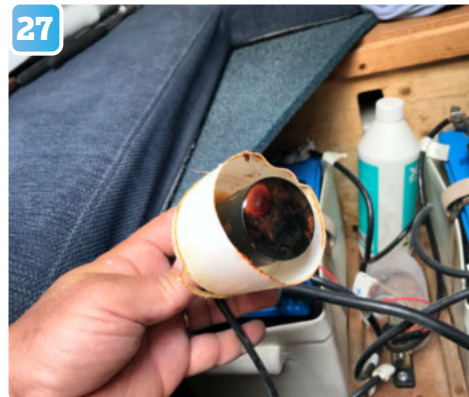
27 Under tiden monteras den gamla givaren bort från sin plats.
