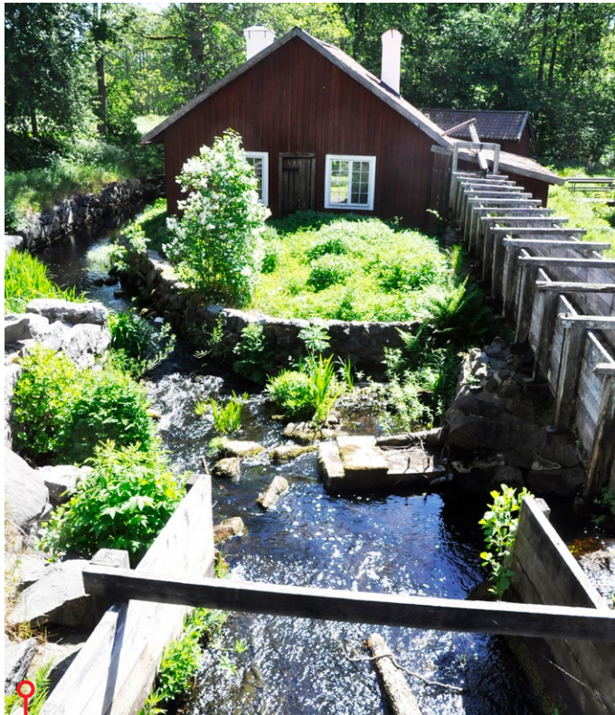
Stora och lilla smedjan är lagskyddade byggnadsminnen.
