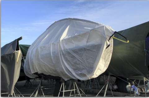
På marknaden finns flexibla rör som detta att spänna upp som takås under presenningen.
