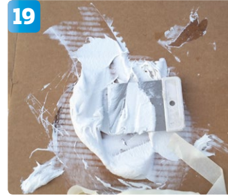
19 Ytan torkas rent med aceton. Limspackett blandas ...
