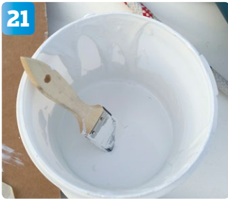
21 På skenorna penslas två lager med topcoat. Torktiden mellan lagren är fyra timmar.
