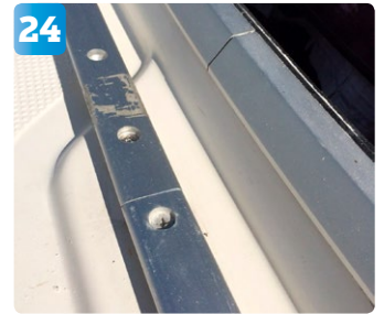
24 De gamla och nya skenornas skarvar är jämna och monteras på samma nivå.
