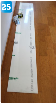
25 För att täcka hålen på innermodulerna tillverkas nya manluckor av vitt plexiglas som är tre millimeter tjockt.
