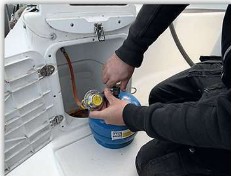
Gasoltuben, även reservtub, ska förvaras i ett avskilt, ventilerat och dränerat utrymme.
