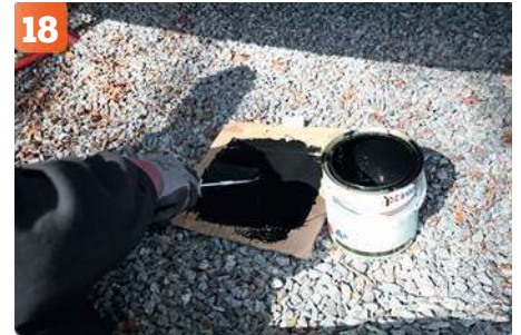
18 Använd rollrar av bra kvalitet som klarar lösningsmedel. Billiga rollrar släpper ofta ull. En bit papp fungerar bra tillsammans med en målarburk istället för rollertråg.
