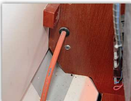
Slangen skyddas vid genomföringen, bra.
