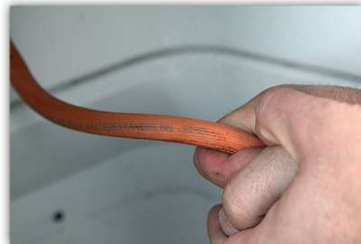
Slangar som är skyddade bör bytas efter tre till fem år. Slangar som utsätts för solljus blir spröda och bör bytas varje år. Slangarna ska vara godkända och märkta.
