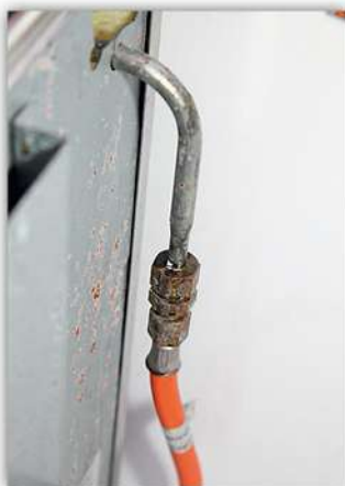
Det allvarigaste felet vi hittade var en sprucken mutter i anslutningen mellan rör och slang bakom en spis. En sådan skada kan få allvarliga konsekvenser om gas läcker ut i båten och spisen sedan tänds.
