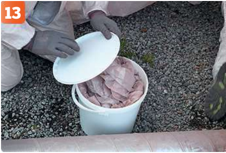
13 Sedan packas allt blästermedel i slutna behållare för att kunna renas och återanvändas.
