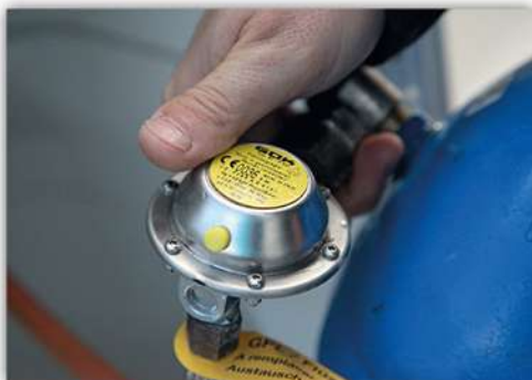
Reduceringsventilen är bland det viktigaste i en gasanläggning. Den ska bytas minst vart tionde år.
