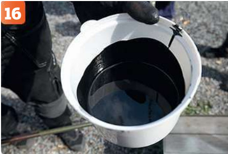
16 Efter tio minuter är färgen slät och fin, färdig att användas.
