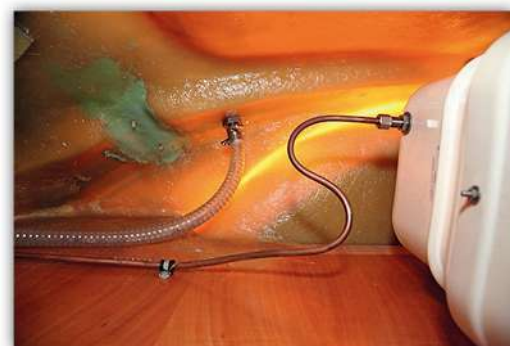
En böj på kopparröret kan ibland finnas för att ge utrymme för värmeexpansion.
