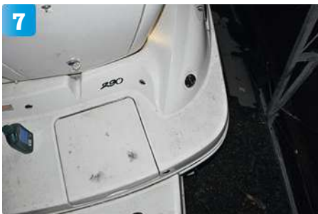
För att kunna få utrymme att installera trimmotorer måste Victor skära upp en del av badplattformen med en sticksåg.
