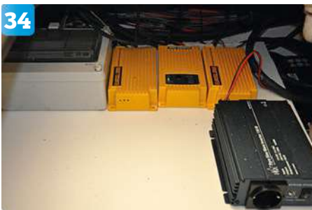
34 Ovanpå batteribanken placerar han en så kallad polywood-skiva där han skruvar fast elcentralen. På skivan monterar han även tre nya batteriladdare för landström och en inverter. För att komma åt batterierna är det lätt att skruva bort skivan.
