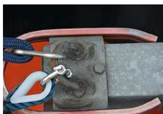
Som alternativ kan flera av hållarna fästas i bulten som håller Y-bommens flytkropp på plats.
