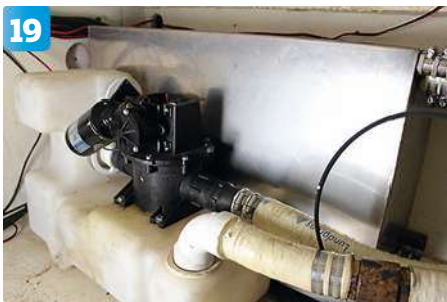
19 En ny septiktank i rostfritt installeras intill där de nya batteribankarna ska placeras i ett stort utrymme under sittbrunnen.
