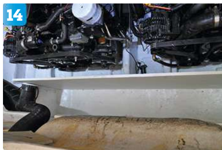
14 Skivorna monteras fast på styrbords- och borbordssidan i motorrummet.
