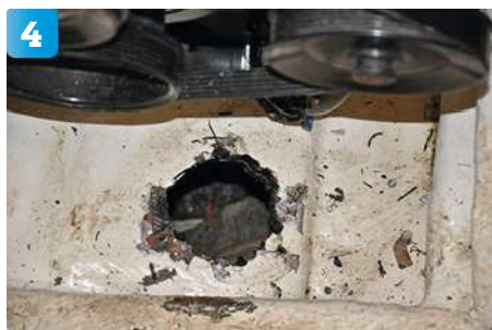
Slangen från septiktanken och genomföringen för toatömningen i motorrummet monteras bort.
