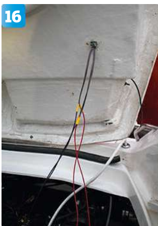
16 Han passar på att montera svagströmselkablar för tre LED-lampor som ska tändas automatiskt då den stora motorrumsluckan öppnas.
