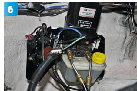
Nästa steg är att flytta motorn till trimplanen under badplattformen för att få mer svängrum i motorrummet.
