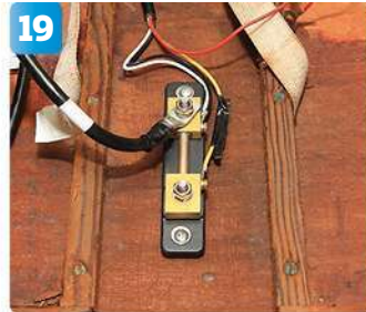
19 När batterierna tillfälligt tagits bort rengörs batteriutrymmet och batteriövervakningsshunten monteras in på platsen mellan batterierna. Multikabelns sladdar från Nasa-centralen kopplas också in.
