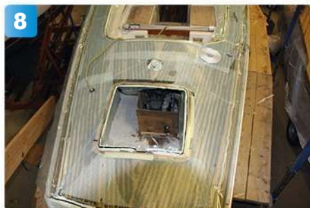
8 Här syns hur teakdäcket har lyfts tillbaka, nåtats, täckts med nät och plastfilm. Luften sugts ut och vakuemet som uppstår undertill pressar teaken mot båtens däck.
