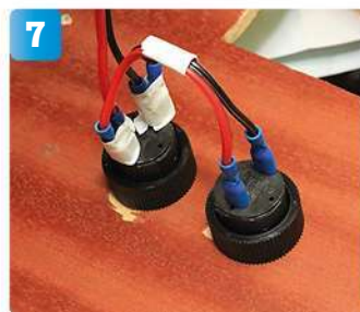
7 12 V-uttagen kopplas in och isoleras på panelens baksida.
