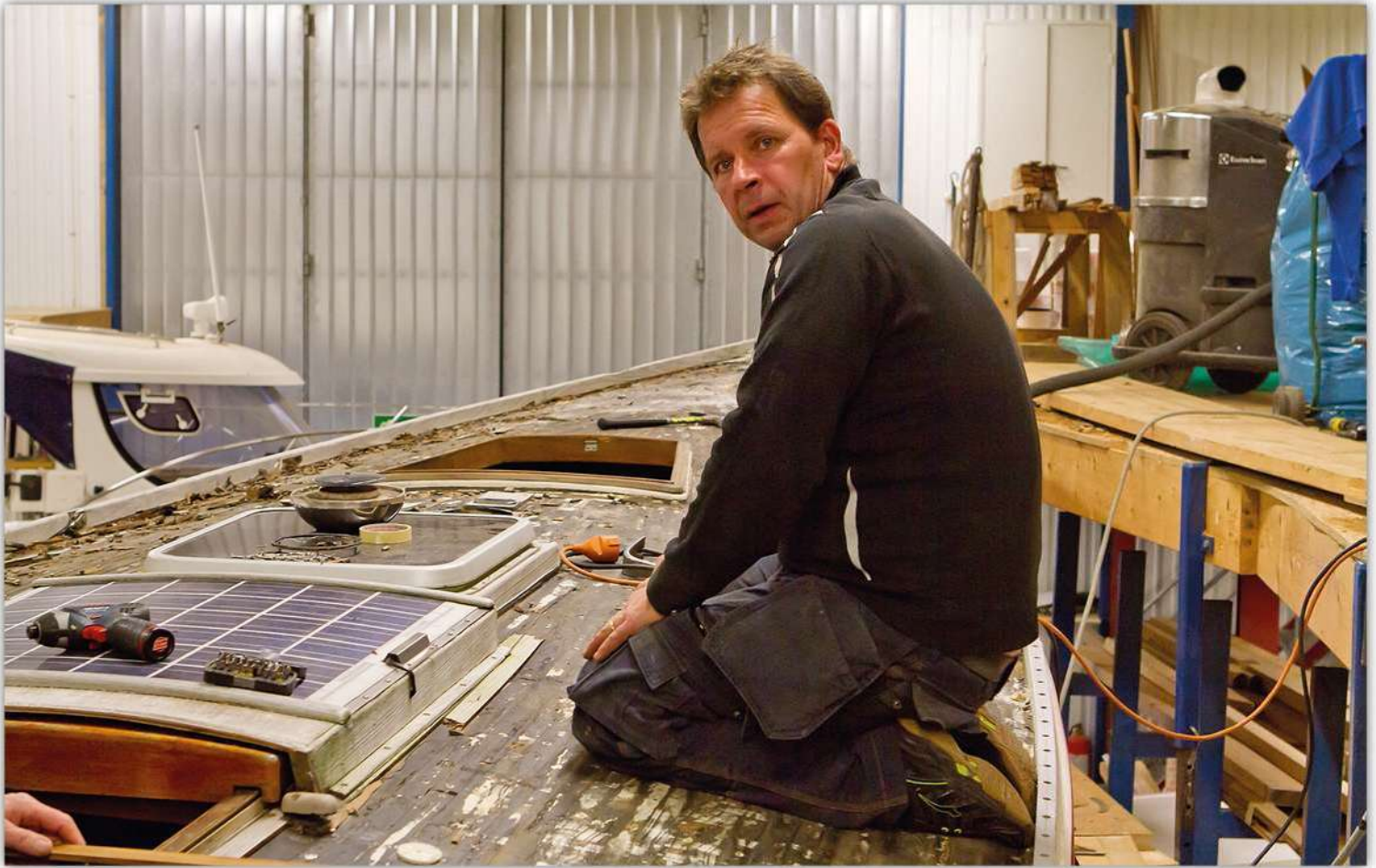
Kai Juusola i färd med att byta teakdäck på en Sveakryssare.
