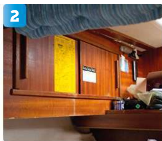
2 Babordsskåpet. Det monteras ner och ska förses med ny teknik.
