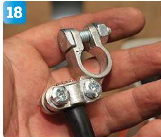
18 Några kabeländar fick dock nya kabelskor.
