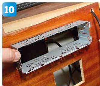
10 Den nya radions fästram passas in och låses fast i panelen. Uppe till höger syns ett hål i panelen där ekolodets givarkabel kommer ut.
