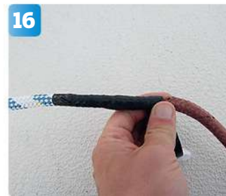
16 Det är bara att mycket noga skarva den gamla änden med det nya fallet. Mjuka upp skarven genom att böja fram och tillbaka så att den löper lätt genom trissan.
