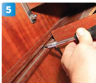
5 För att få bort handfatets in- och utskjutningsanordning monterar vi bort den ena väggskenan.
