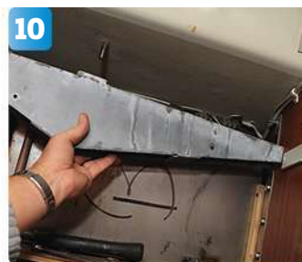
10 Här är det galvaniserade röstjärnet löst och sista panelen borttagen.
