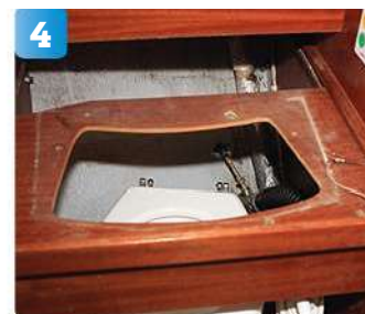
4 Med tvättfatet borta går det lättare att se vad som finns bakom, bland annat den gamla slangen som går längs skrovsidan från toan upp till septiktanken.
