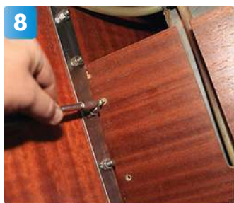
8 För att komma åt septiktanken skruvar vi även bort panelerna och hyllan framför tanken.
