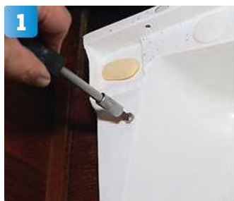
1 Vi börjar med att montera bort tvättfatet.
