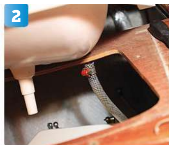
2 Slangar måste kopplas bort från tvättställskranen.
