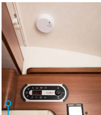
Ingen brandsläckare i LMC men väl en brandvarnare vid entrédörren.
