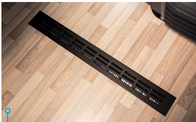
LMC har vattenburen Aldepanna med likaledes vattenburen golvvärme. Prima!
