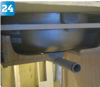
24 Diskhon bakifrån. Här kommer avloppsanslutningen att gå.
