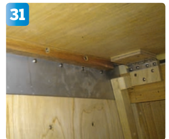
31 När locket skjuts upp så vinklas gångjärnen och stoppet tar i de små tråklossarna. Detta gör att locket inte går att skjuta för långt fram och att det inte kan lossna från spisen.
