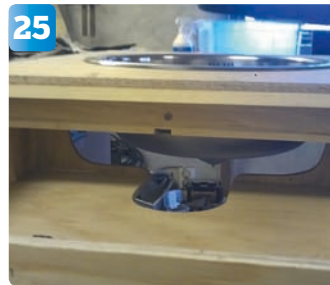
25 Eftersom han har en låda under diskhon är han tvungen att såga ett hål i den för att avloppsanslutningen ska kunna få plats.
