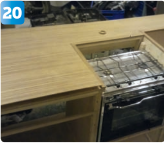
20 Därefter provar han in teaskivan som ska ligga ovanpå själva modulen och göra att det blir en snygg arbetsbänk.
