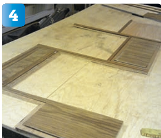
4 Det första han gör är att såga ut alla fronter i konstruktionsmahogny och i teakplywood för att få en uppfattning om hur det kommer att se ut.
