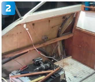
2 Fredrik börjar med att riva bort det gamla. Det nya kommer att bli djupare och gå ända in till skrovet.
