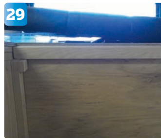
29 Fredrik har även gjort ett lock som ska ligga ovanpå spisen och gå att skjuta bakåt. Här syns locket när det är bakåtskjutet och listerna som det vilar på.
