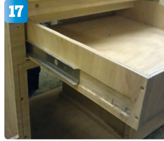
17 I själva lådan har Fredrik fräst ur ett spår för att skenan ska passa. Här har han inte satt fast skenan än, utan testat bara att den fungerar.
