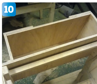
10 Bakom skenorna, och spisen, bygger Fredrik ett stuvfack för att utnyttja den extra platsen som han har fått mot skrovet.
