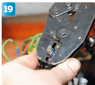
19 Nya kabelskor kläms fast.
