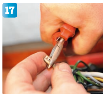
17 Kabelskorna klipps bort.
