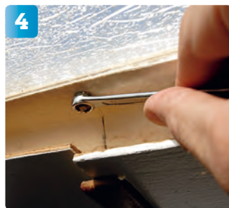
Dags att köra igång med att lossa skruvarna på den befintliga luckan.
