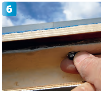
6 Bricka och mutter på undersidan håller ramen på plats.
