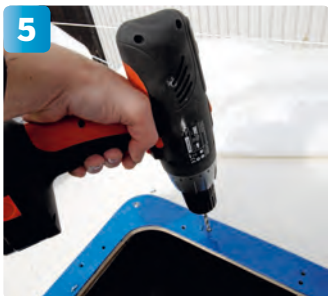
5 Skruva fast ramen. Hörnskruvarna först.
