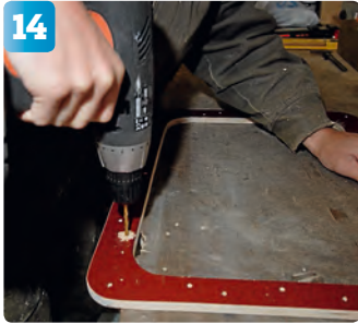
14 Borra hålen för att fästa ramen.
