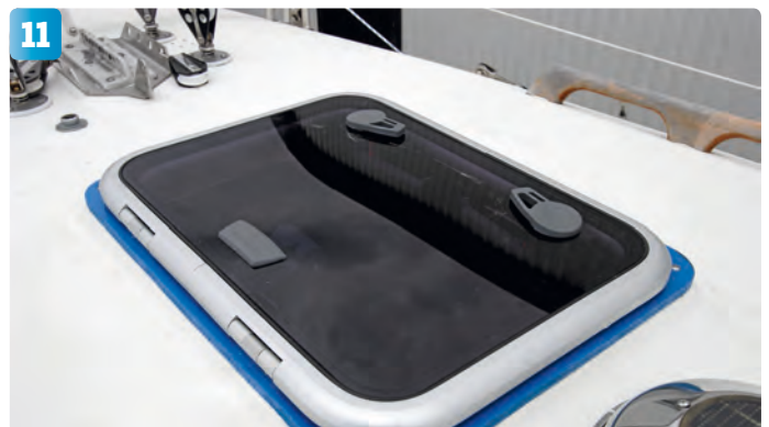
11 Luckan är på plats. Nu är det bara att låta ljuset flöda in.
