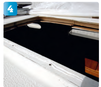
4 På med tätningssmassa ...
