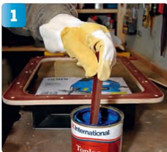
1 I exemplet används samma topplack som på skrovets dekorrand och vattenlinje.
